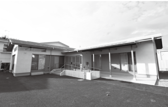
▲完成した八乙女自治公民館
