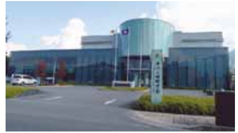
・市川大門庁舎（本庁舎）
