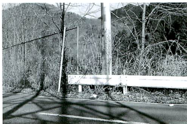
●フェンス設置予定地(大同入地区)
