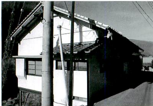
●改修予定の大同12組公民館
