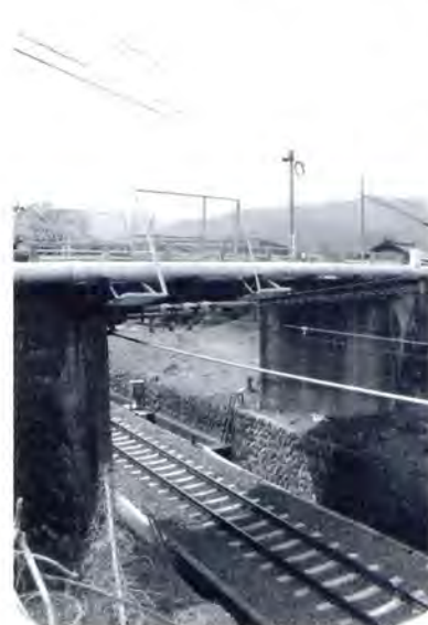
矢作・上野線三珠陸橋
