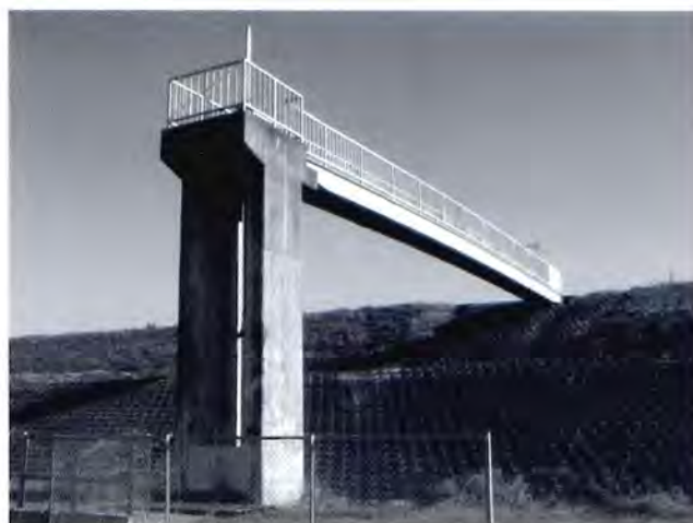
大塚揚水機場堰柱
