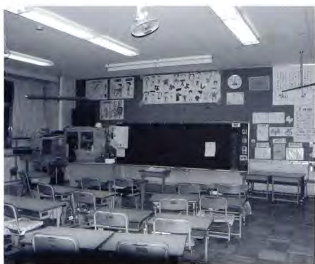
小学校エアコン設置予定
