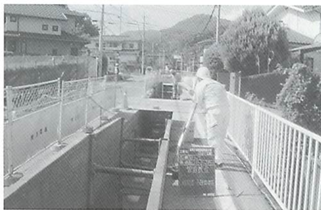
公共下水道工事
