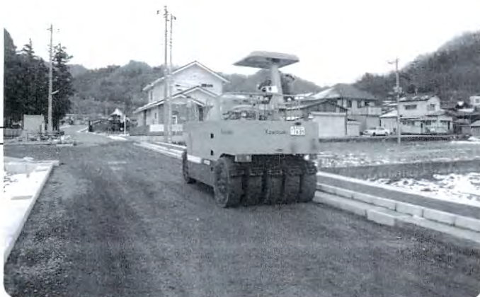
進められる道路舗装
