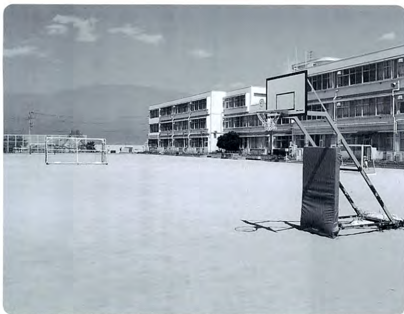
改修予定の市川小学校グラウンド
