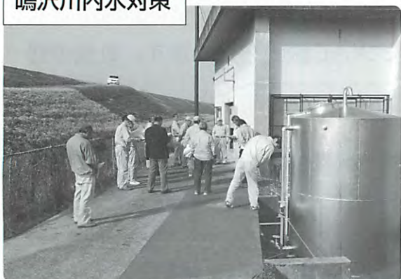
高田排水機場 鳴沢川内水対策
