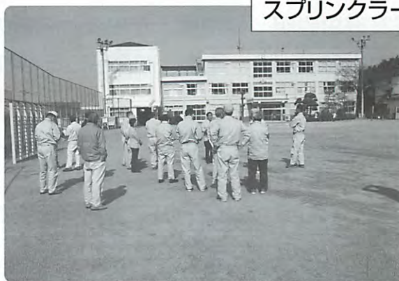
大塚小学校 グラウンドの整備・ スプリンクラーの設置
