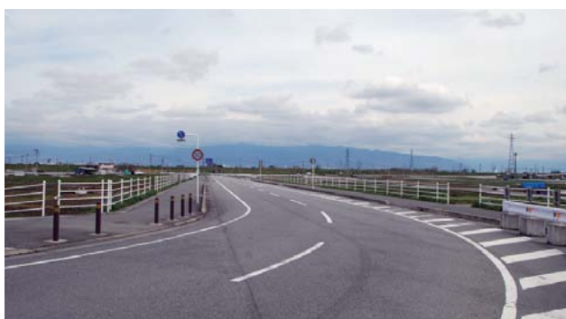
新田橋付近の道路
