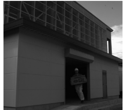
防災基盤整備事業 (消防費) 1億275万円 大規模地震、その他の災害に備え耐震貯水槽や防災備蓄倉庫などの整備を進めました。(写真・市川大門防災備蓄倉庫)
