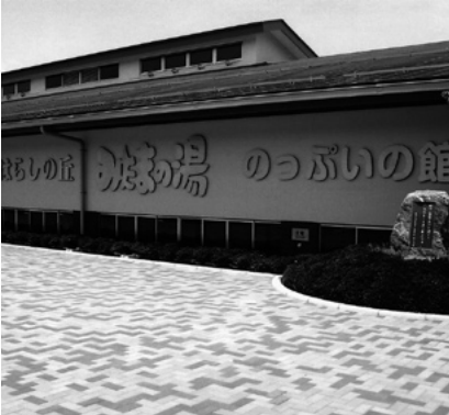
みたまの湯施設増改築事業 (商工費) 4,187万7千円 みはらしの丘「みたまの湯」に厨房、休憩室、ボディケア室を増築しました。(写真・みたまの湯)
