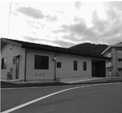
公営住宅整備事業(岩間地区) (土木費) 4億1,790万円 町営住宅岩間団地、西河原地域交流センターの建設、周辺道路改良工事などを行いました。(写真・西河原地域交流センター)
