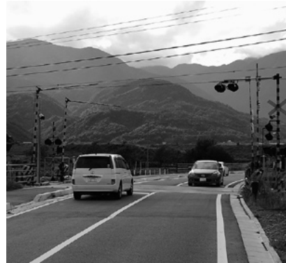
町道大鳥居踏切移転拡幅事業 (土木費) 6,571万円 県道とバイパスを結ぶ連絡道として、町道波柳線を新設。それにともない身延線をわたる踏切移転を行いました。
