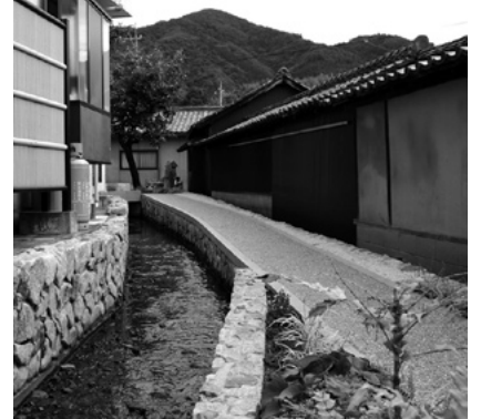
市川地区中央部まちづくり事業 (土木費) 3,252万8千円 市川地区中央部の景観を生かしつつ、道路、水路、広場、防火水槽などの整備を行いました。(写真・柿の木の辻)
