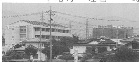
▲町営富士見住宅1号棟と建設中の2号棟
