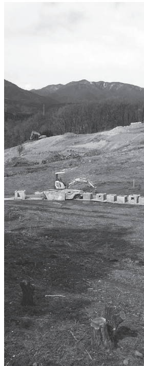
▲工事の進む大木圍場整備
