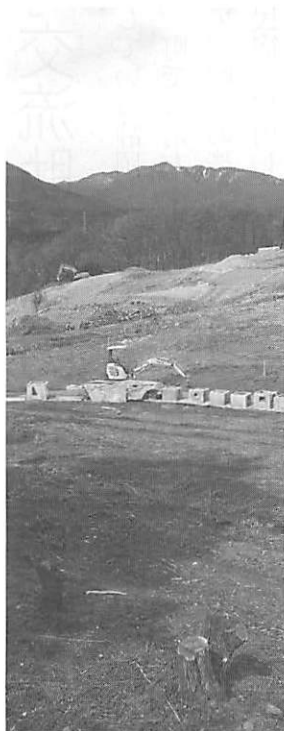
▲工事の進む大木園場整備
