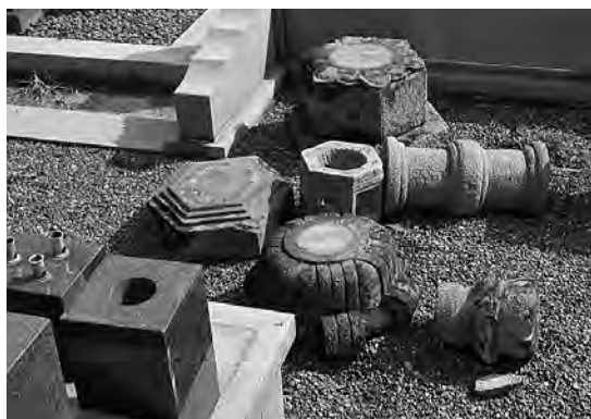
▲3/15 おとなり身延町でも震度5弱を観測。墓石が崩れるなどの被害が発生した(身延町役場提供)
