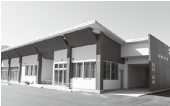
▲完成した大同地区公民館
