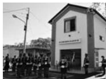
▲新築された詰所
