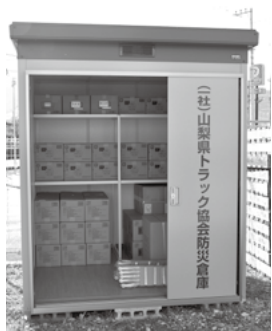
▲山梨陸送有限会社 敷地内の備蓄倉庫
