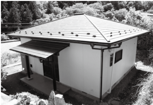
▲修繕された三帳集会所
