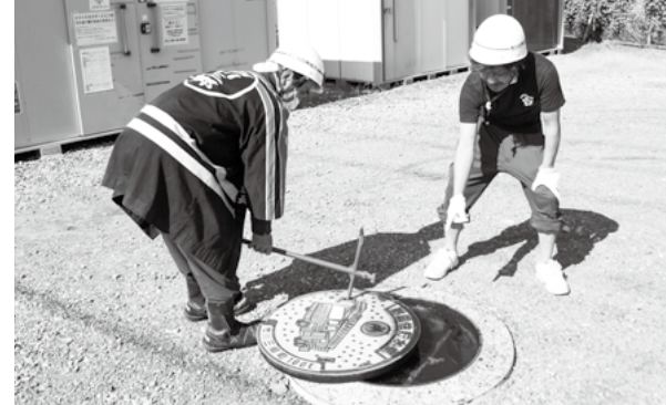
▲消防団による防火水槽点検(市川大門)
