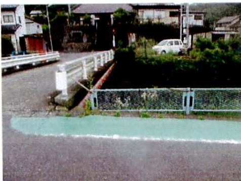
(写真資料 3) 山田川沿いフェンス
