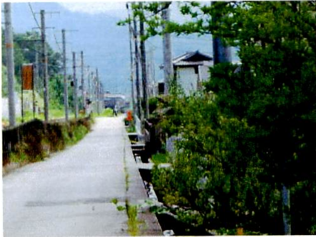
(写真資料 1) 落居駅周辺の路肩排水溝
