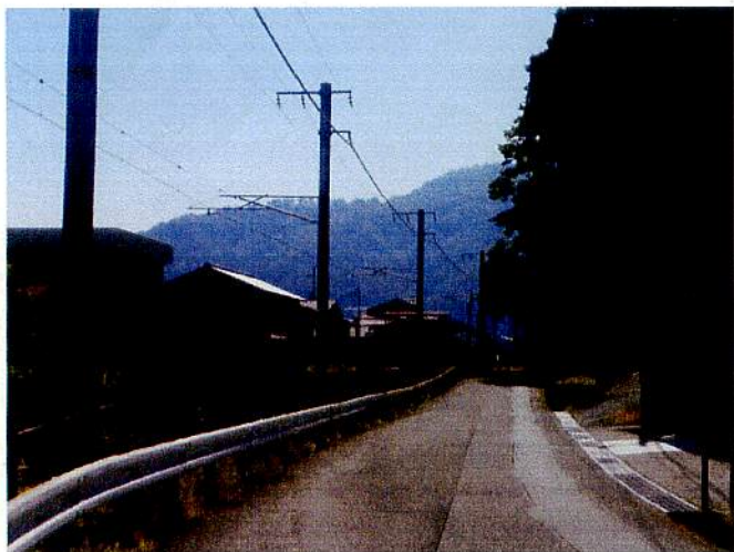
③ 学校下の階段を下ったところの側溝
