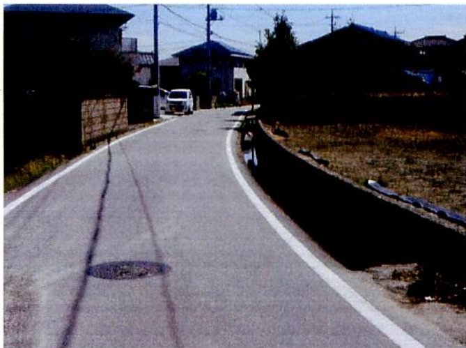
④ 二ノ宮神社から高田公民館にかけての側溝
