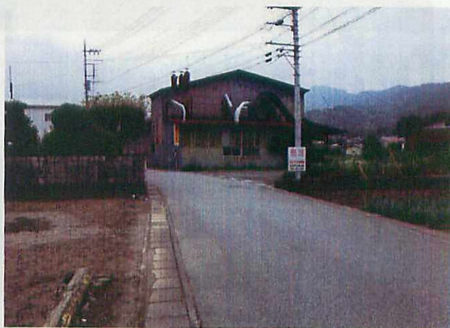
写真⑧大塚県営団地カーブ
