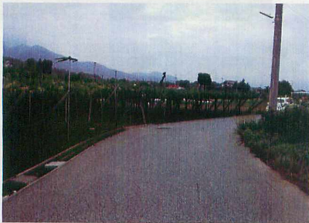
写真⑧大塚県営団地カーブ
