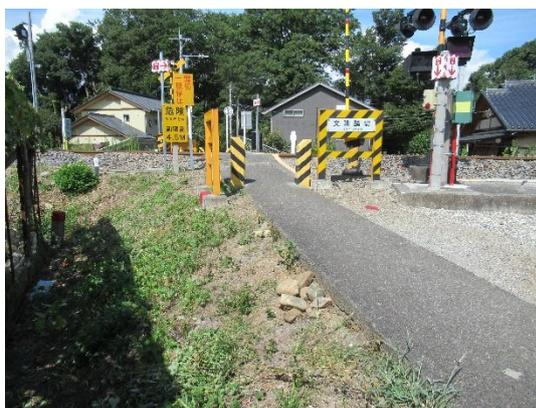
舗装と坂道脇の土の法面との段差が大きくなっており、児童が転倒する事案が発生している。舗装幅の拡張や段差の解消などの整備をお願いしたい。
