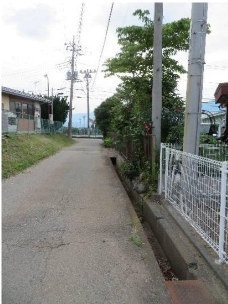
写真② 側溝の安全対策（ふたがない）
