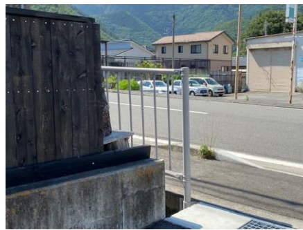
塀があり, 歩行者も運転者も安全確認が難しい。
