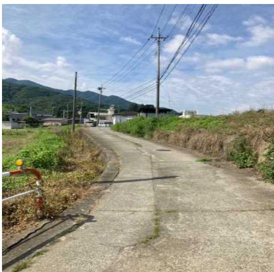
【道林踏切方向の写真】
