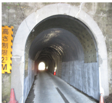
シート補強による剥落防止対策（R3）
