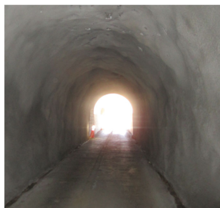
素掘り部を吹付補修（R4）
