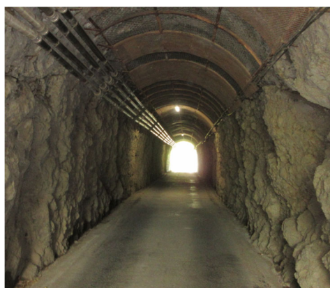
鴨狩隧道：内部の素掘り部（H30）
