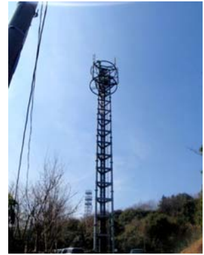
・景観的な配慮が求められる携帯アンテナ塔
