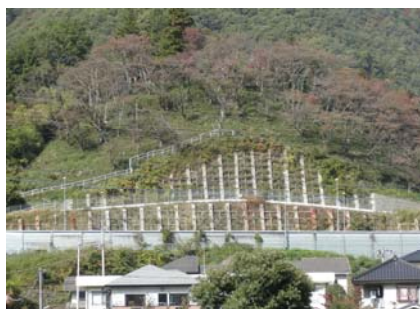
・縦方向のフレームを強調した法枠
