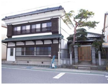
図8⑦ 本通り沿いの母屋(厚壁蔵造り) 一瀬亮次邸：大正時代
