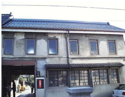
図8④ 本通り沿いの母屋 (蔵造り 長屋門風) 丹頂堂
