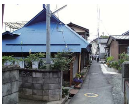
図 8 ㉔ 奥に建てられた元茅葺き屋根 の長屋
