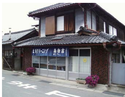
図 8 ㉗ 幅員の広い横丁には母屋が面する
