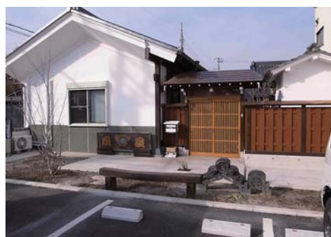
図 8 ⑲ 母屋を取り壊したが、建築部材を活かした憩いの場を提供
