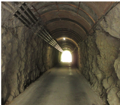
鴨狩隧道：内部の素掘り部（H30）
