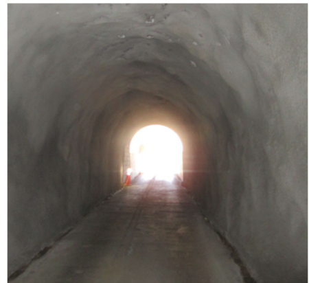
素掘り部を吹付補修（R4）
