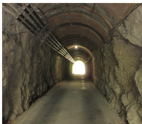
鴨狩隧道：内部の素掘り部 (H30)
