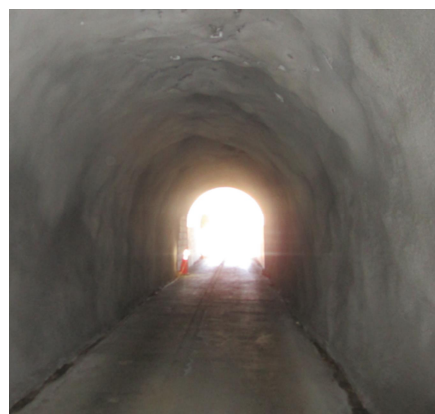
素掘り部を吹付補修 (R4)
