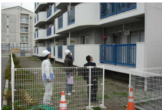
外壁クラック等確認作業風景
