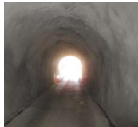
素掘り部を吹付補修（R3）
