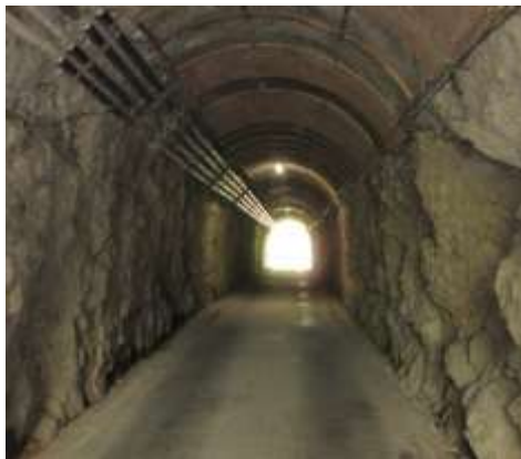
鴨狩隧道：内部の素掘り部（H30）
